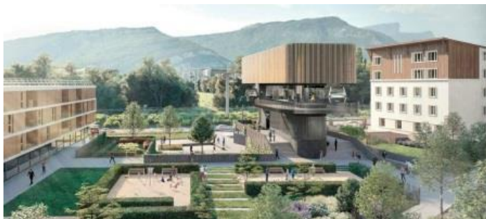
Vue de la station G6 selon un axe Est-Ouest
